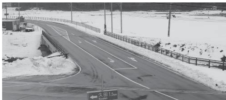
昨年、架け替えした小間生橋（主要地方道）
