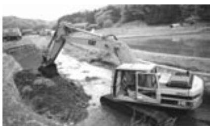
河川内の堆積土砂除去作業
